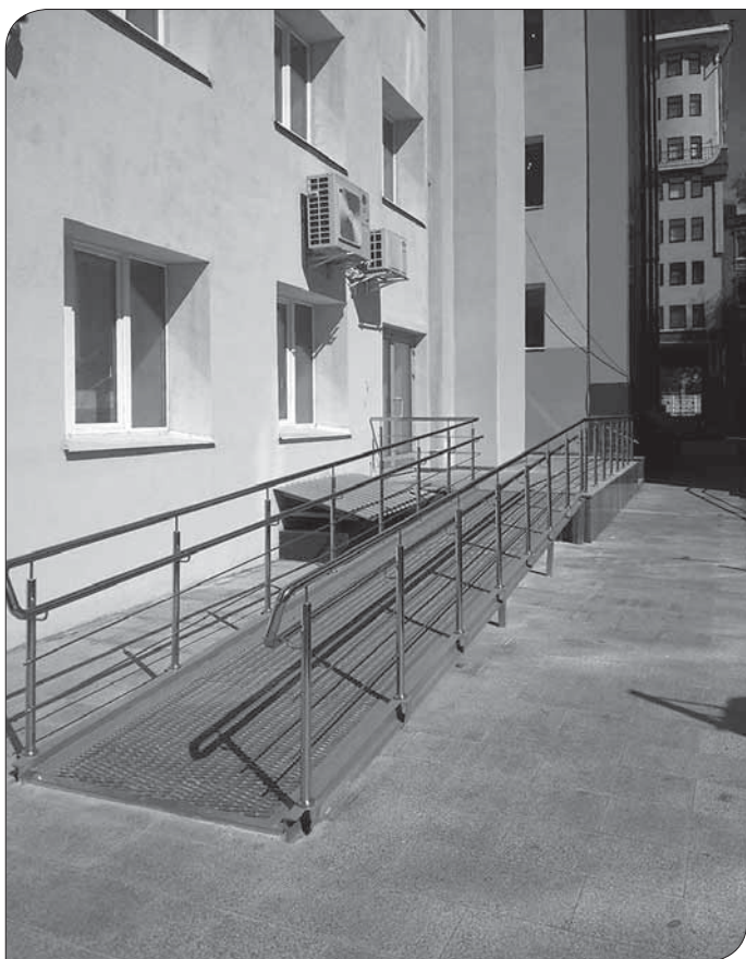
Пандус до будівлі адміністрація Київського району ХМР по вулиці Чернишевська, 55
